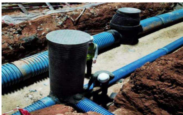
图7 塑料成品检查井及井圈。
