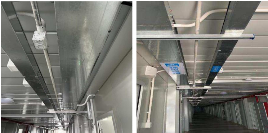
图17 优化后的桥架现场安装实景图。
